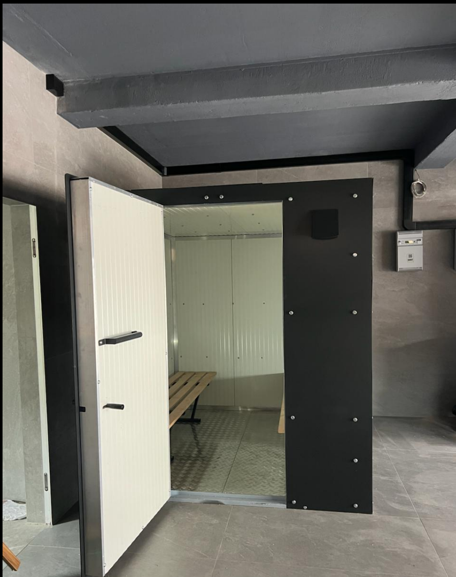
Wnętrze kabiny ochronnej (widok na ławki oraz podłogę ryflowaną)
